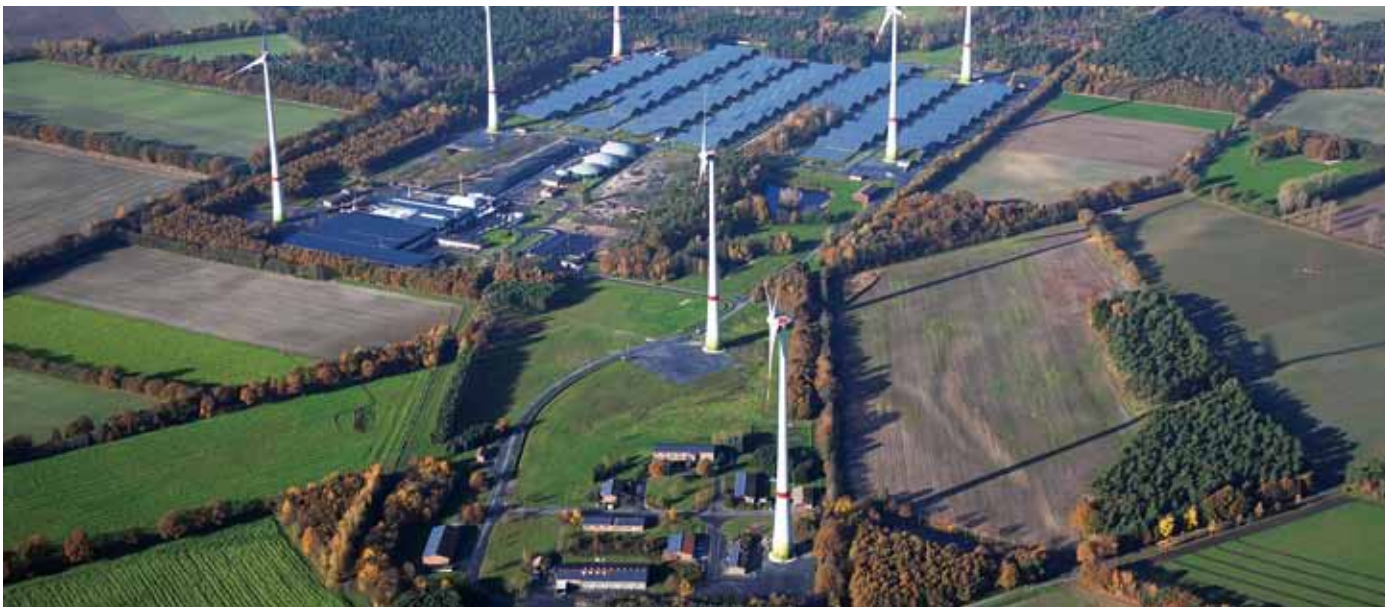
Sieben Windkraftanlagen, eine Biogasanlage auf Basis nachwachsender Rohstoffe, ein Biomassekraftwerk (der Bioabfallbehandlungsanlage des Kreises Steinfurt) und eine Photovoltaik-Anlage auf den Bunkerdächern erzeugen grüne Energie mit einer Gesamtleistung von 29 Megawatt.
