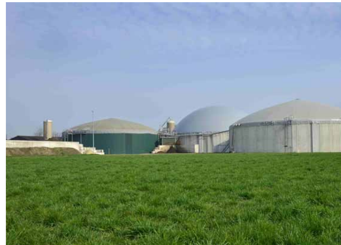
Die Biogasanlagen von Bernd Stricker und Augustinus Moormann haben eine Gesamtleistung von 2,75 MW el und liegen im niedersächsischen Bakum.
