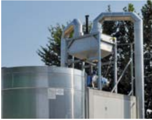
Die Fermenterseparator gewährleistet einen konstanten Gehalt an Trockensubstanz.
