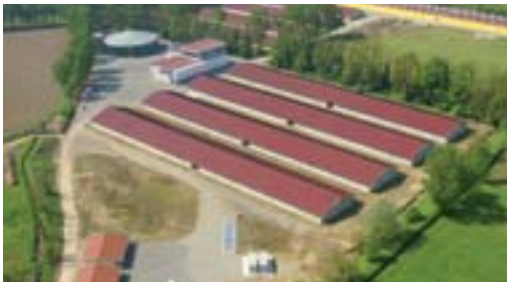
Die Biogasanlage in Casaleto Ceredano
