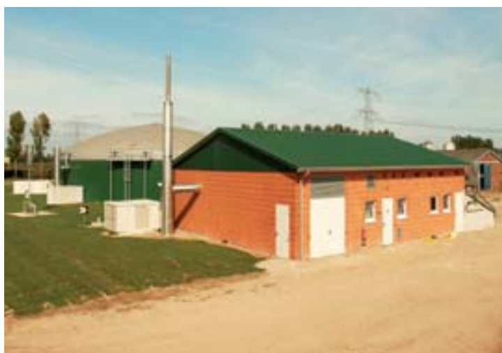
Das Technikgebäude und der Fermenter in Bergharen. Er hat ein Nettovolumen von 3.400 Kubikmetern.
